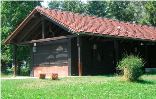
Bild 6: Sanitärgebäude mit Blitzschutzsystem als sicherer Unterstand
