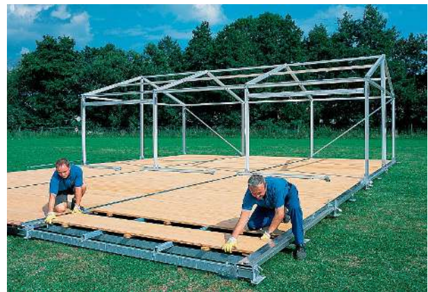
Bild 7: Festzelt mit Kassettenboden und Erdungsanlage bietet Schutz bei Gewitter (Foto: Röder)
